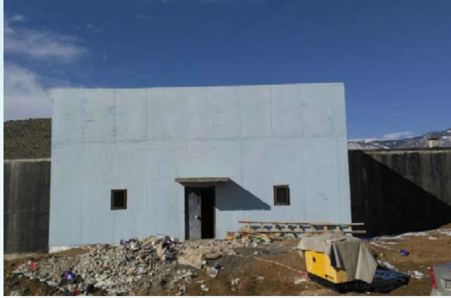
6.246.000 TL Oltu İlçesi 2500 m 3 Depo ve İçmesuyu Tamamlandı
