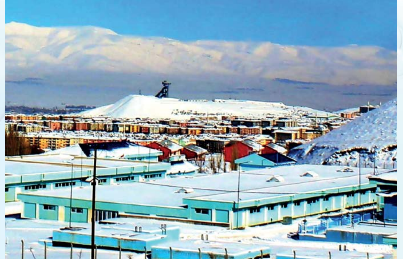
İçme Suyu arıtma tesisi
