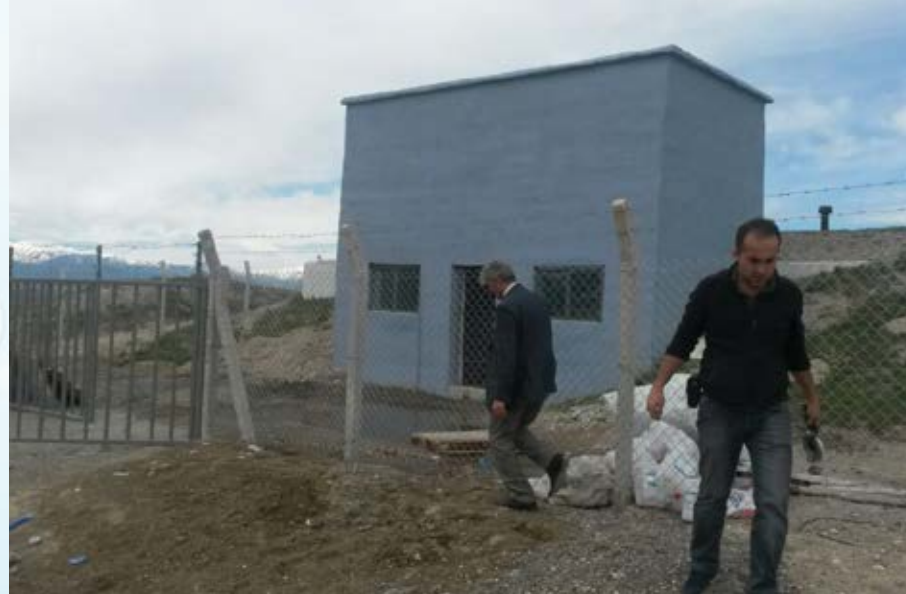
Köprüköy ve Karaçoban İçmesuyu Depoları Tamir Edildi
