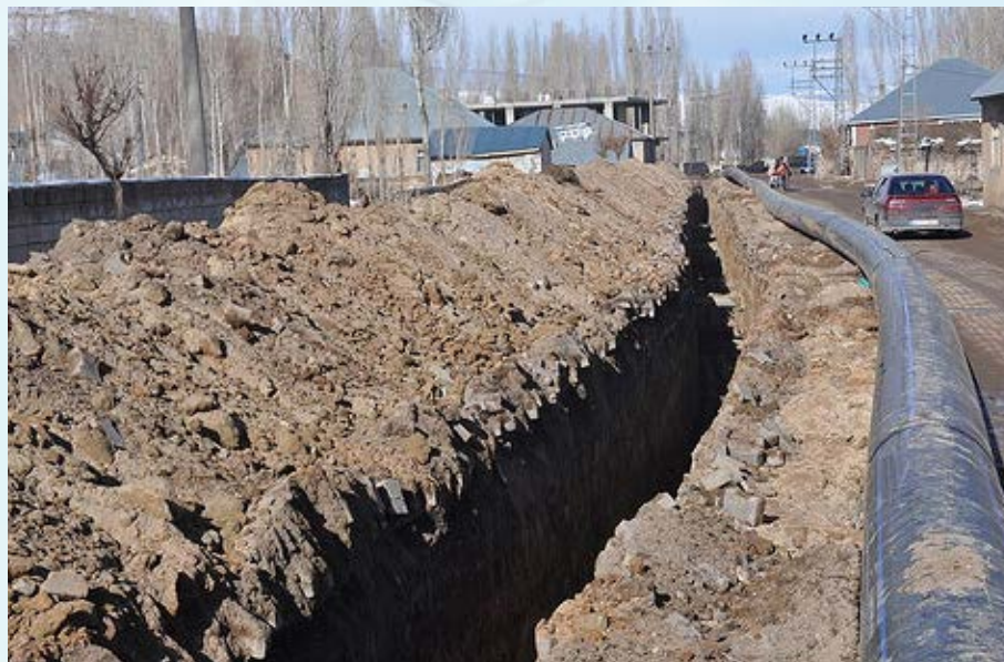
7.433.000-TL Horasan İsale Hattı ve Arıtma Tesisi Tamamlandı
