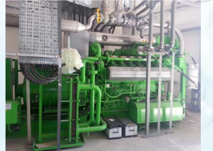
Biogaz Jeneratörü
