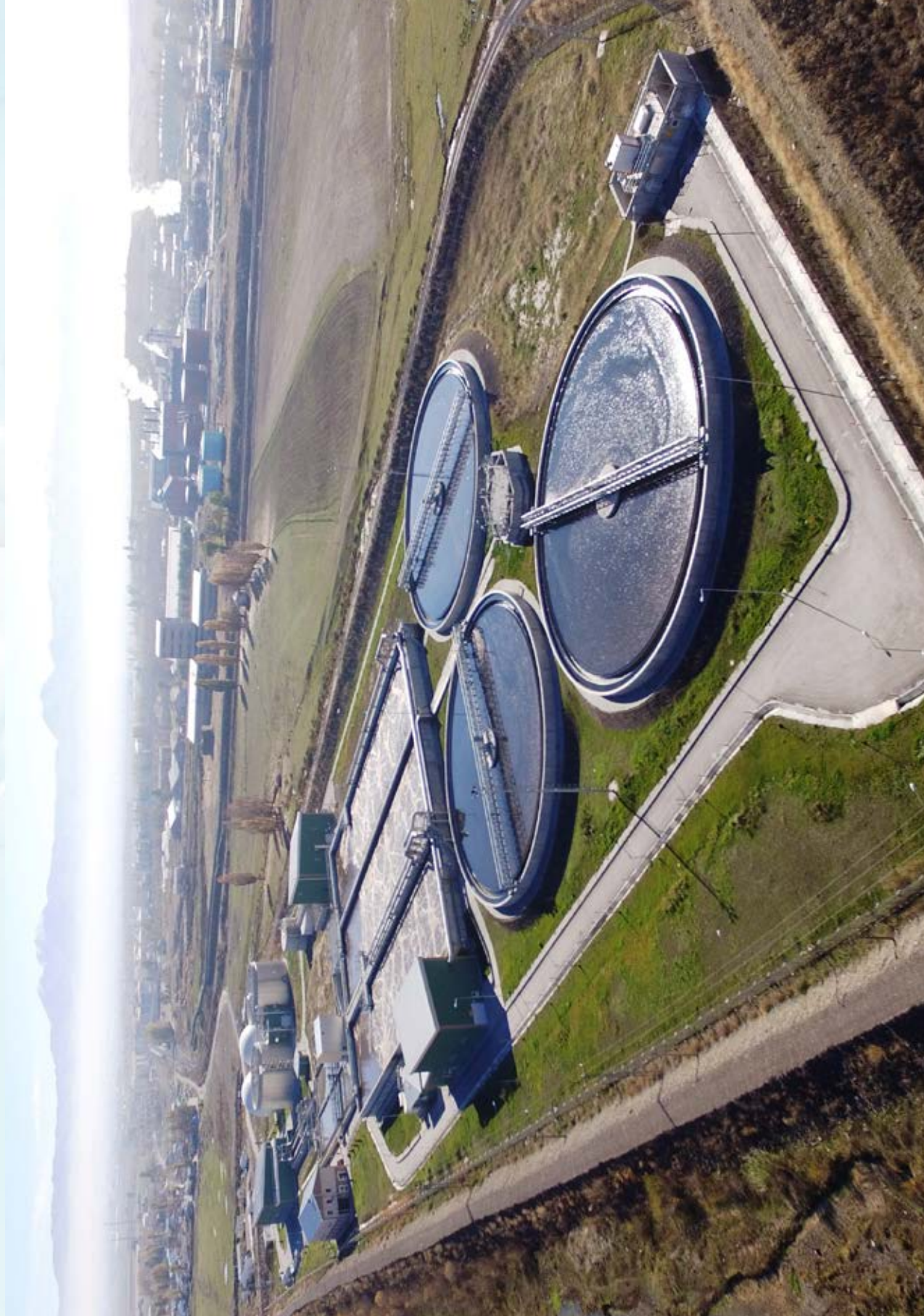
Erzurum Atıksu Arıtma Tesisi
