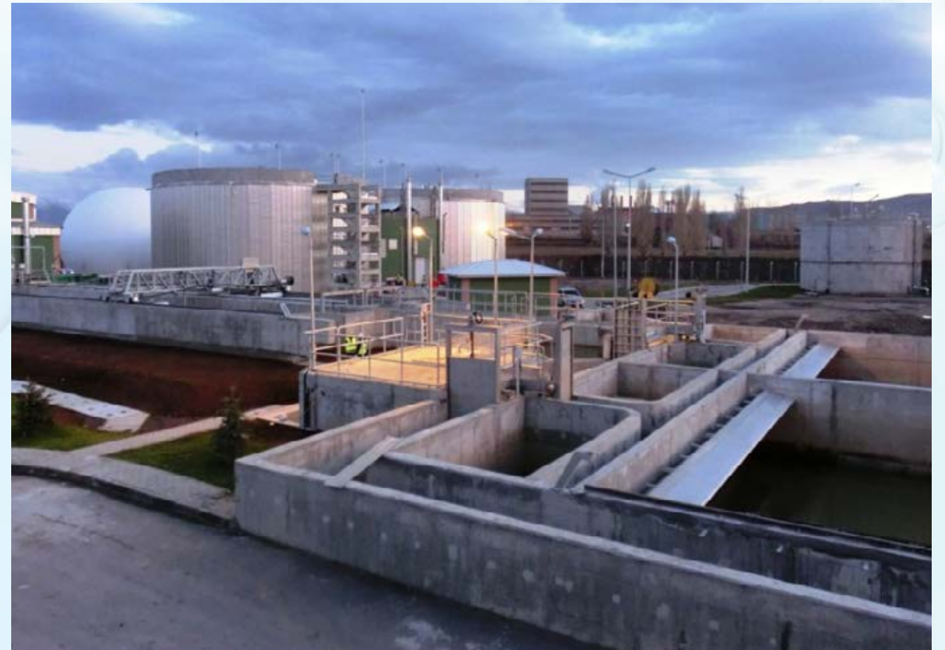
Atıksu Arıtma Tesisi
