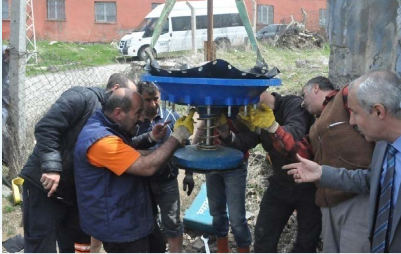
Yukarıdağ depo önünde bulunan arızalı basınç düşürücü vana membranının ve sızdırmazlık contasının değiştirilmesi.
