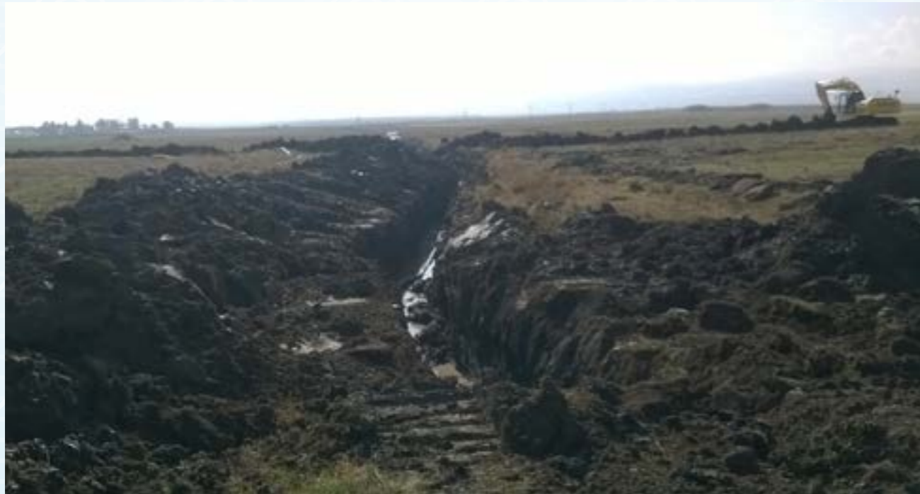
Memba drenaj yapımı
