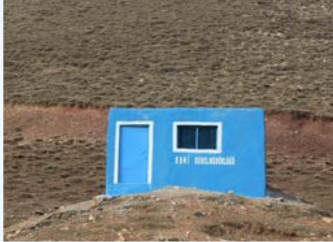
Akdağ Su Deposu Yeni Hali
