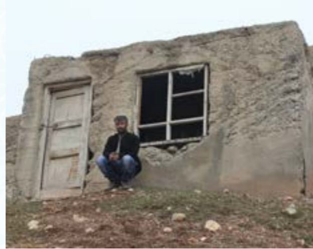
Akdağ Su Deposu Eski Hali
