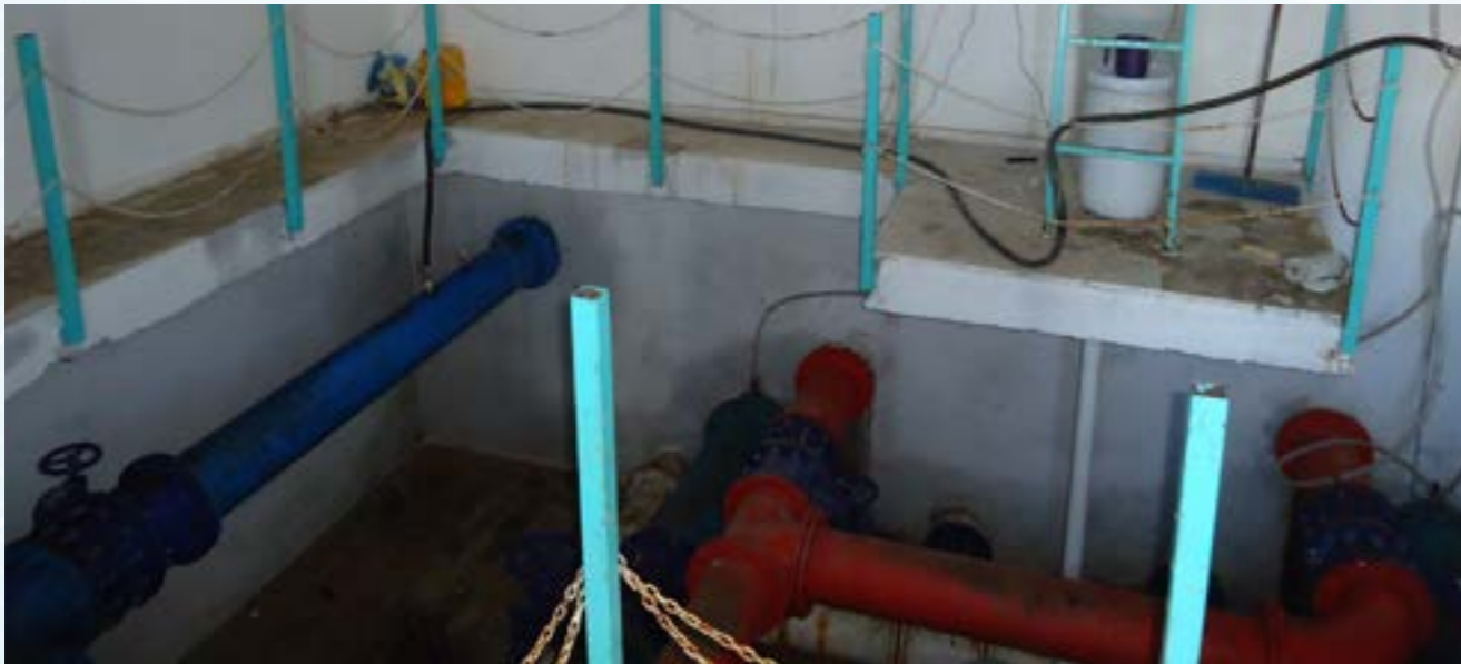
İlçelerde Kurulan Otomatik Klorlama Sistemi
