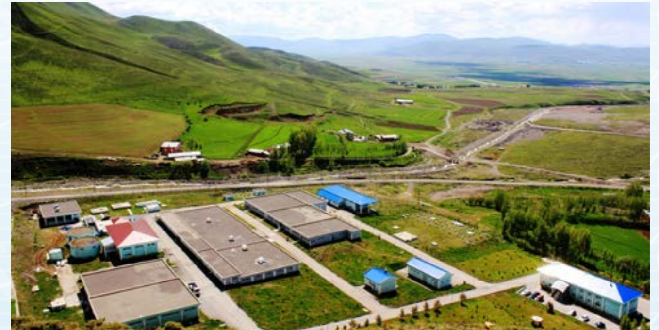
İçmesuyu Arıtma Tesisi
