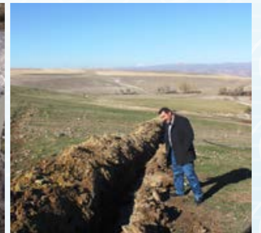
36.657 Metre İçmesuyu Hattı Yapıldı
