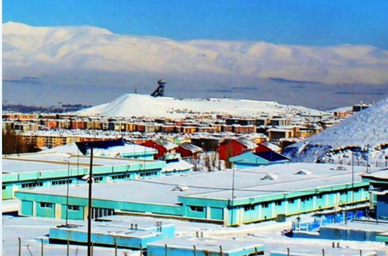
İçmesuyu arıtma tesisi
