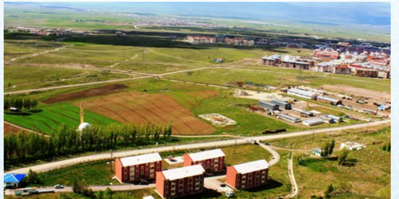
Arıtma Tesisi Lojmanları ve 15 000 m 3 lük su deposu
