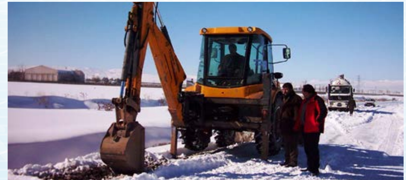
14.587 metre yeni kanalizasyon hattı yapılmıştır.
