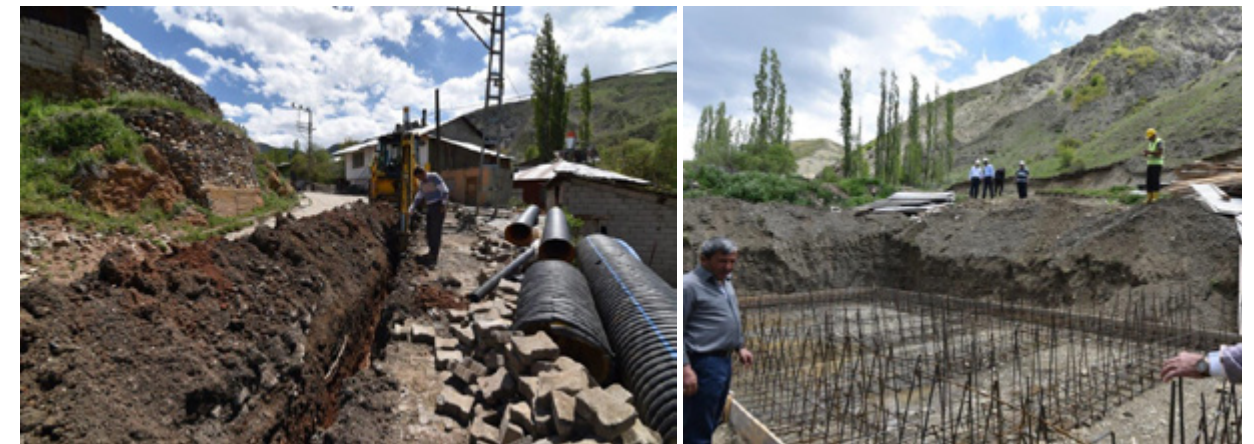
İlçelere 143.479 m kanal hattı ve 8 adet fosseptik yapıldı.
