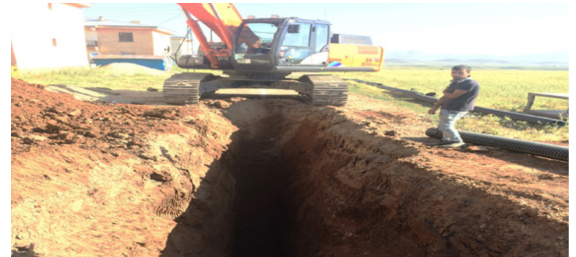
211.934 m.kanal hattı yapımı için 6.954.000 TL harcanmıştır.
