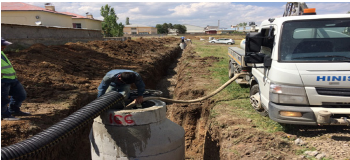
SU-KAP projesi kapsamında Hınıs ilçesinde yapılmakta olan 60 km.kanal hattının 52 km.si 12.483.000 TL harcanarak tamamlanmıştır.
